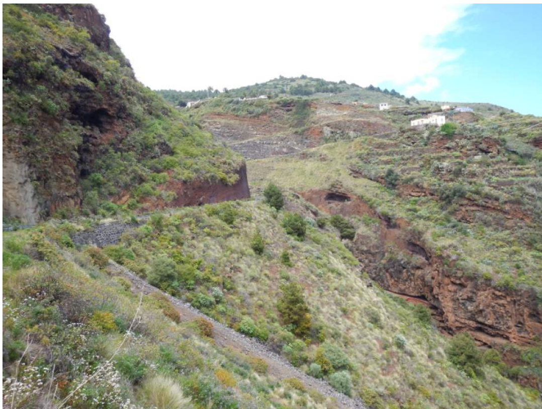
Figura 8: Área potencial del sabinar (hábitat de interés comunitario 9560) muy alterada por las obras de la LP-1, y donde al margen de unas pocas sabinas también se observan algunos pinos aislados.
