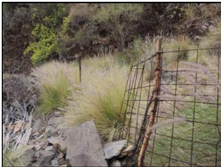
Ilustración 26: Cerramiento deteriorado en la zona baja de la ZEC.
